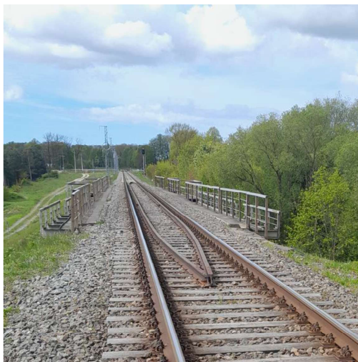
2.2.1 pav. Esamo kelio ant tilto fotofiksacija.
